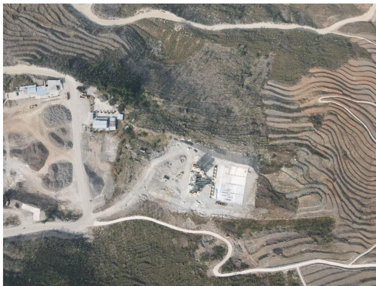
隧洞出口拌合站
