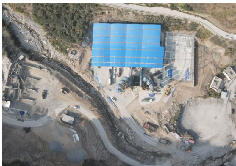
入口拌合站及便道
