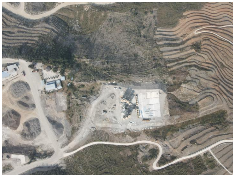
空压机房及便道
